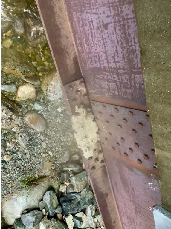
Grout on ds splice
